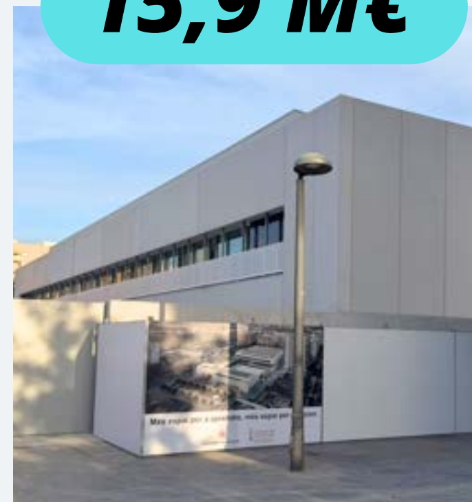
CEIP FERNANDO DE LOS RÍOS NUEVA CONSTRUCCIÓN
